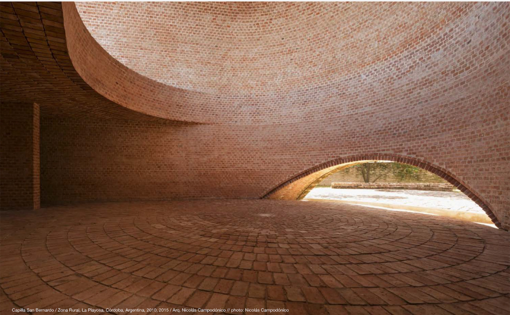
Capilla San Bernardo / Zona Rural, La Playosa, Córdoba, Argentina, 2010, 2015 / Arq. Nicolás Campodónico // photo: Nicolás Campodónico
