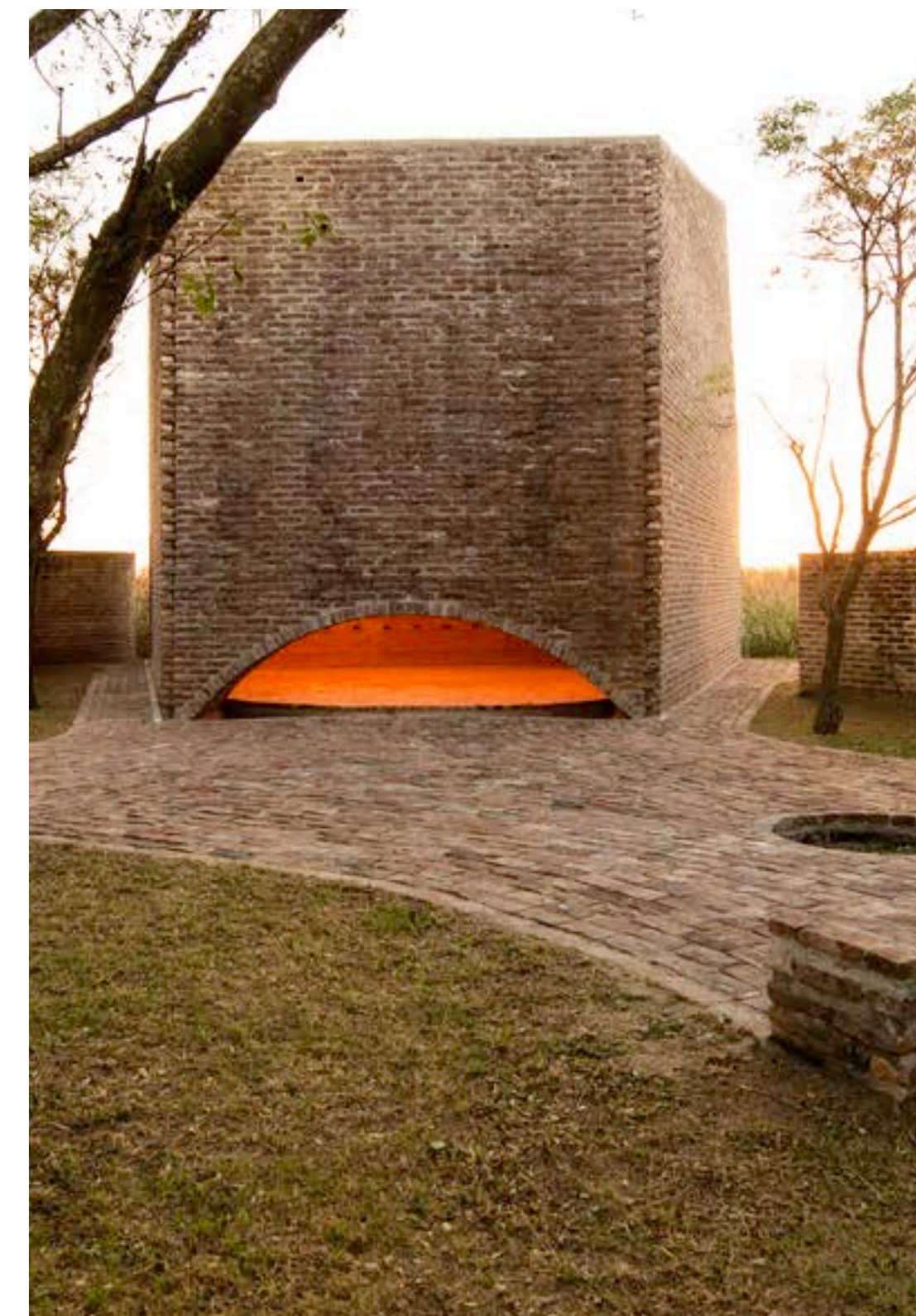
Capilla San Bernardo / Zona Rural, La Playosa, Argentina, 2010, 2015 / Arq. Nicolás Campodónico // photo: Nicolás Campodónico
